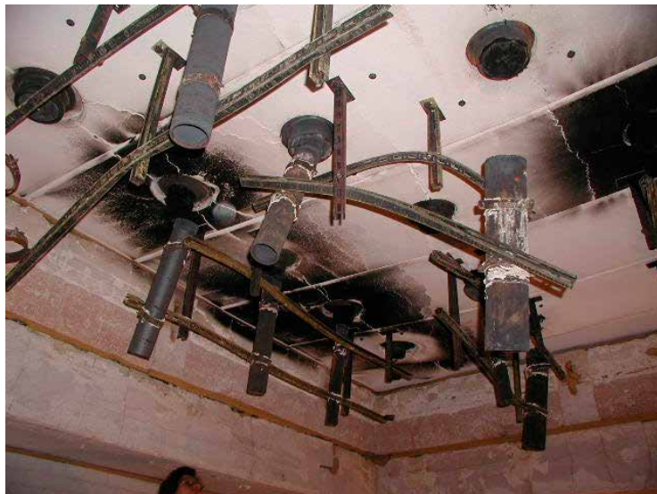
Рис. 3. Чугунные трубопроводы после проведения испытаний в огневой камере
