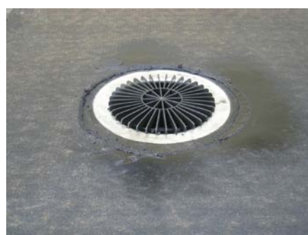
5. Так должна выглядеть воронка после укладки гидроизоляции
