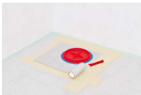
10. Нанести жидкую гидроизоляцию на поверхность стяжки, а также снизу и поверх фартука гидроизоляционного комплекта
