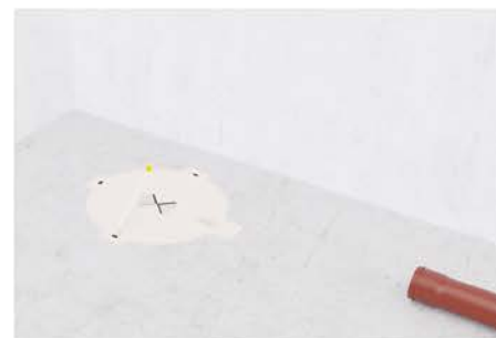
3. При помощи шаблона определить позиционирование корпуса сифона (выпуск) и разметить отверстия под крепеж
