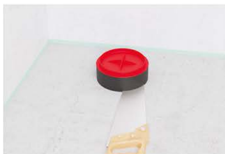
8. После застывания стяжки, выступающую часть корпуса отрезать ножовкой
