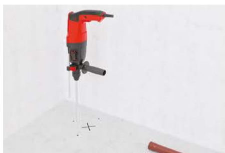
4. Просверлить отверстия под крепеж
